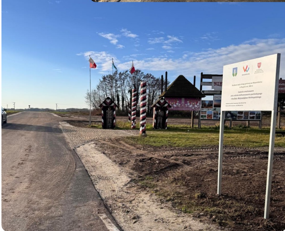
Budowa drogi gminnej Wszembórz – Cieśle Małe
