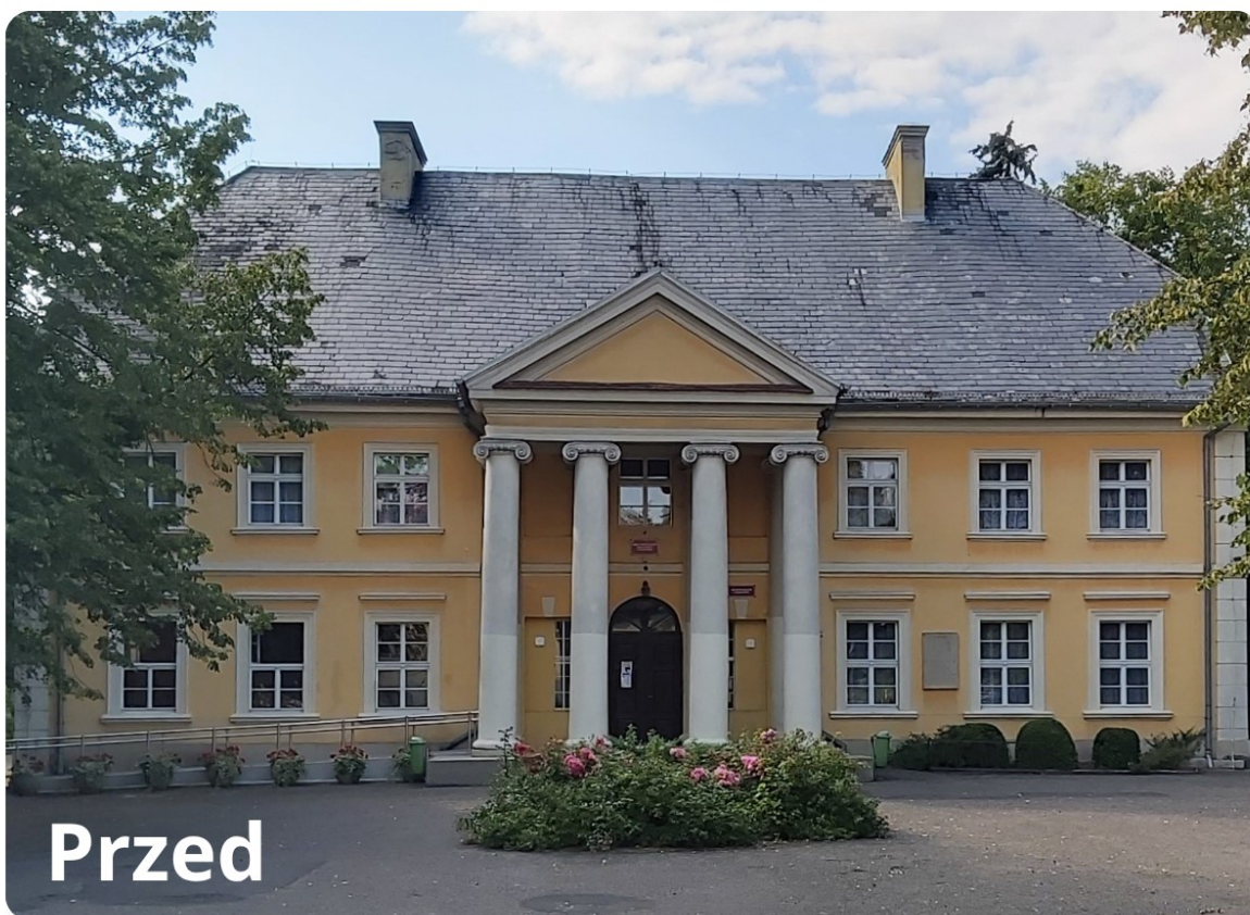
Remont elewacji i dachu pałacu Reymonta w Kołaczkwie.
