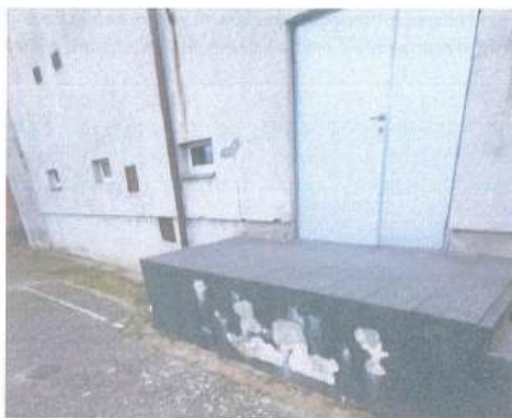
Zdjęcie nr 2 Zamocować barierki wykonać remont schodów
