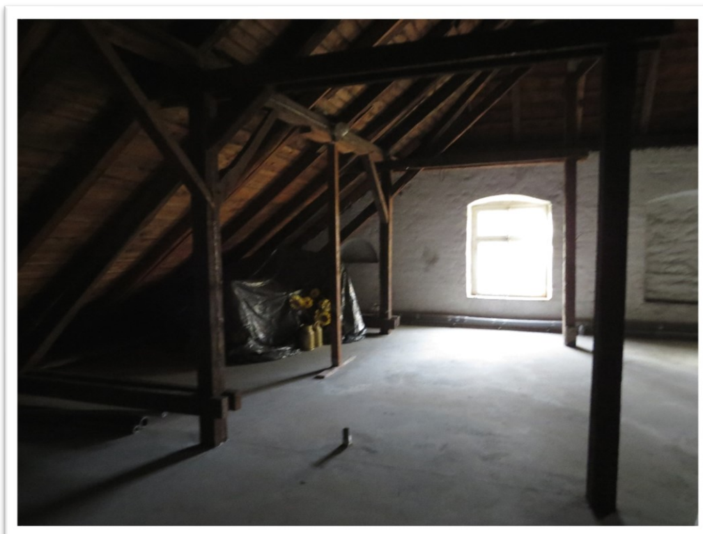
Ocieplenie stropu poddasza budynku Pałacu Reymonta
