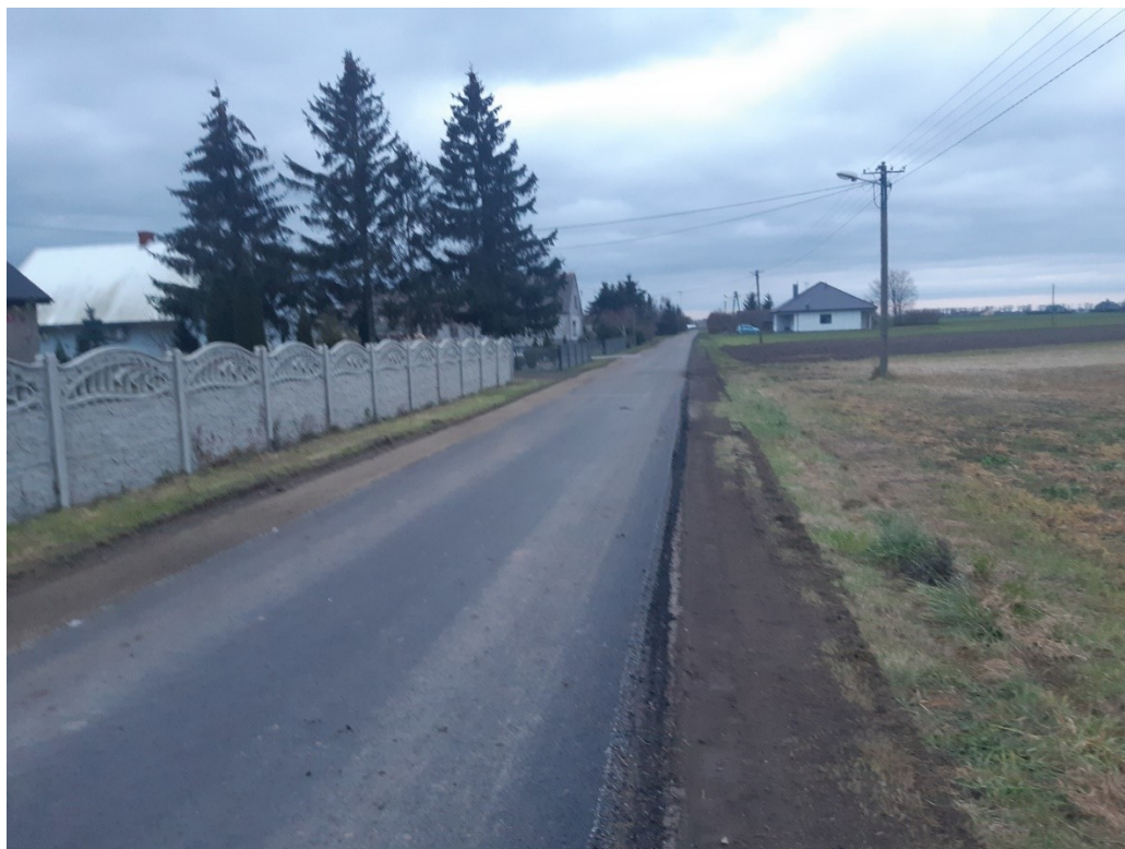
Remont nawierzchni drogi gminnej w miejscowości Zieliniec dz. nr 109 obręb Zieliniec oraz dz. Nr 37 obręb Żydowo – droga o długości 978m
