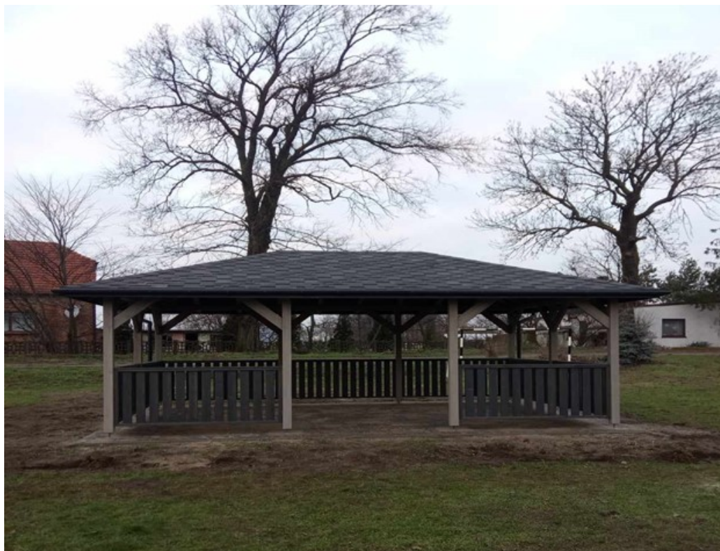
Budowa altany w Krzywej Górze, dz. nr 134/10
