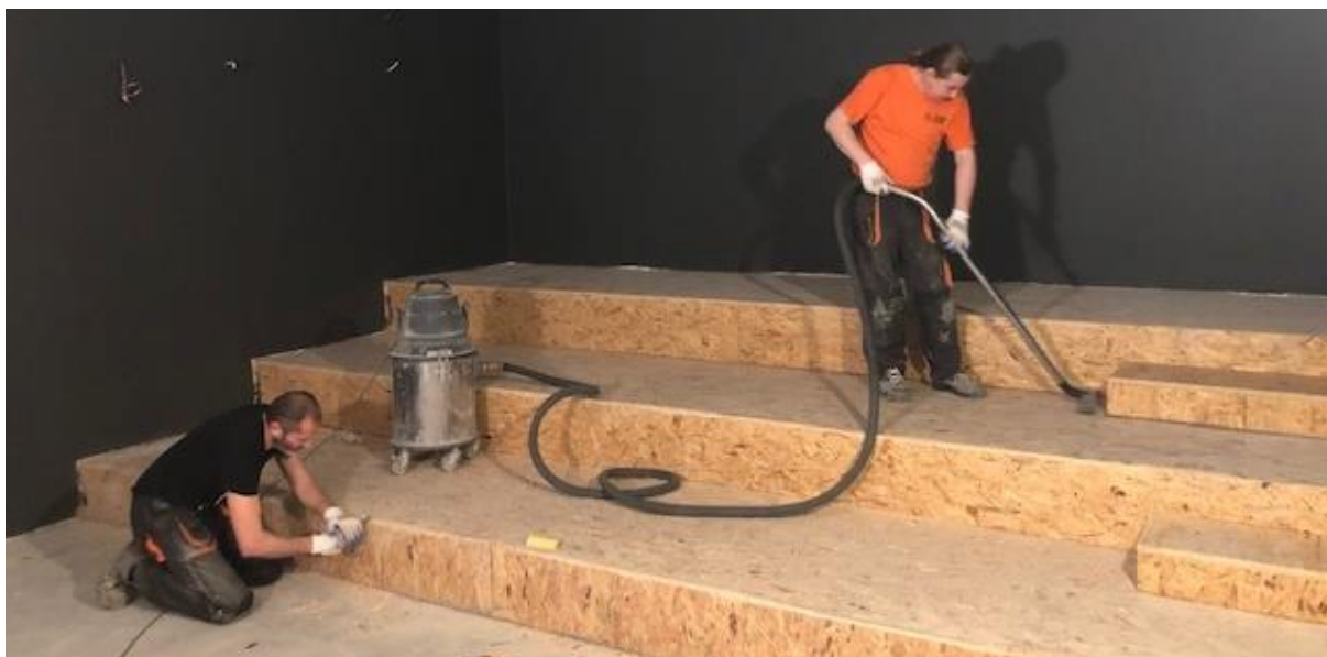
Rys. 49: Podest pokryty płytą i przygotowany do pokrycia wykładziną
