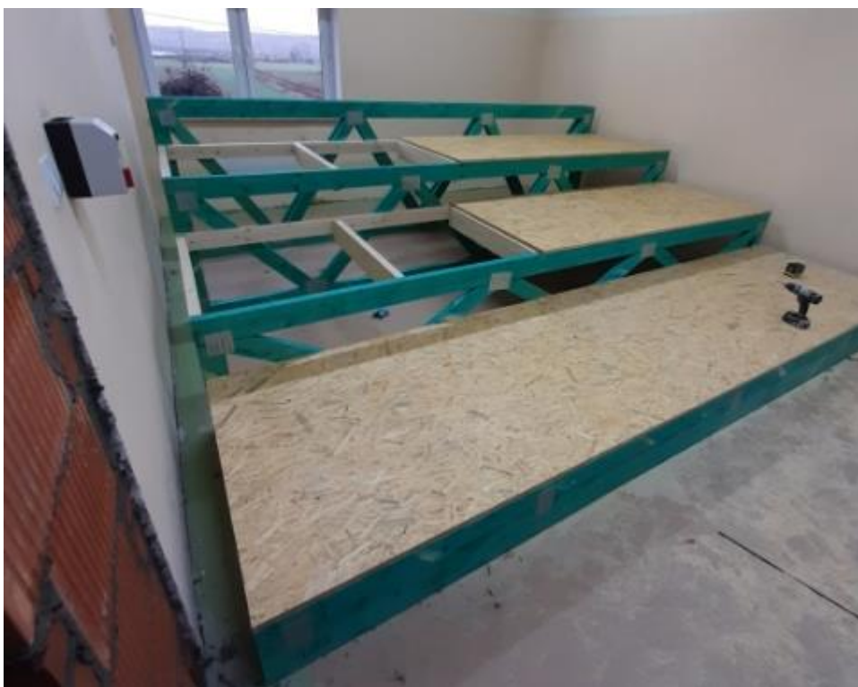
Rys. 47: Inna konstrukcja podestu drewnianego. Po lewej pozostawione miejsce na okładzinę wygłuszającą.
