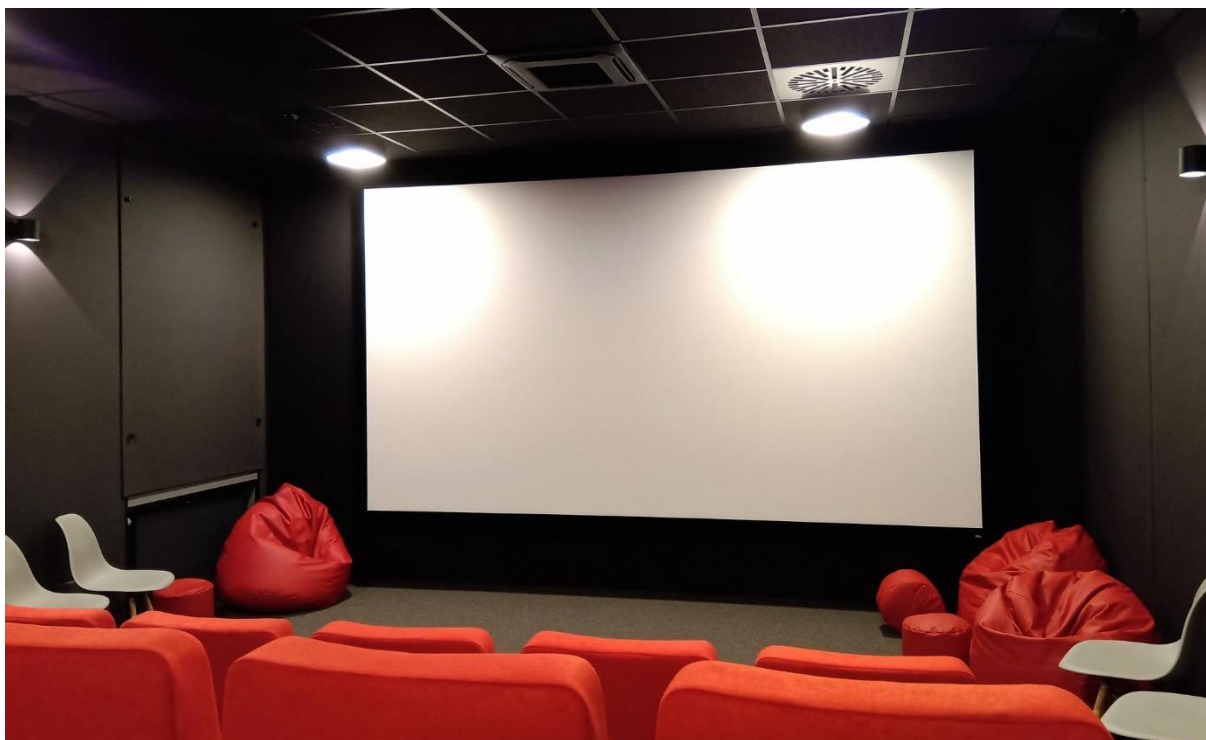
Rys. 39: Ściana akustyczna z ekranem pokryta w całości tkaniną akustyczną.
