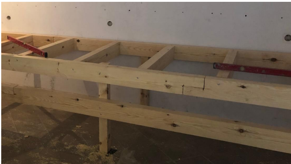
Rys. 46: Drewniana konstrukcja podestu. Belki izolowane są od ściany (niewidoczną na zdjęciu) matą izolującą 10 mm.
