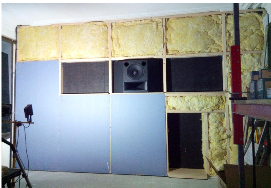
Rys. 20: Częściowo zabudowany stelaż z wstawionym jednym głośnikiem. Czarne wypełnienie otworów to szklowana wełna mineralna 50 mm.
