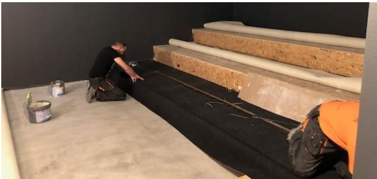
Rys. 54: Pokrycie podestu wykładziną
