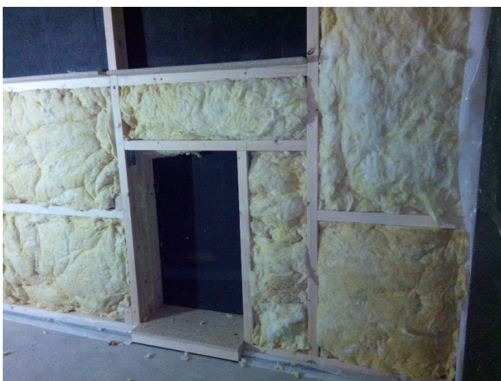
Rys. 35: W otworach na głośniki widać warstwę szklawionej wełny 50 mm.
